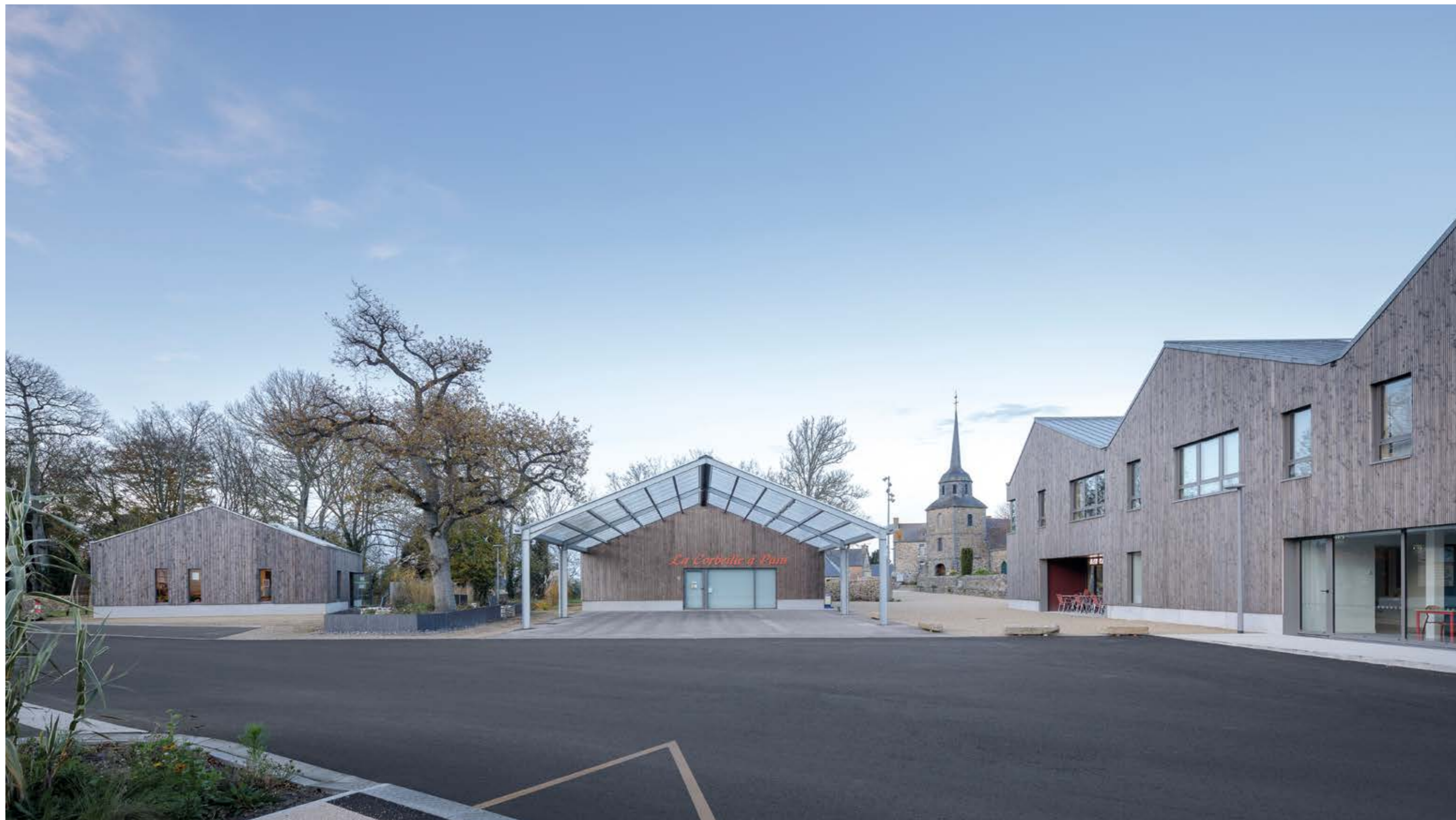
Aménagement du centre-bourg de Tréveneuc / Tréveneuc (22) Nunc Bretagne Architectes, B. Houssais Architecture
